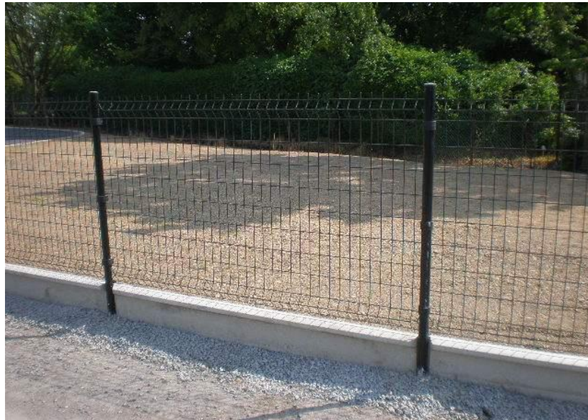
Photo 1 : Clôture en façade sur rue et en limite espaces communs
